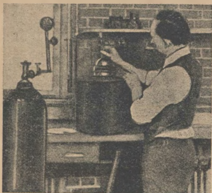
Рис. 160. Погружные калориметрической бомбы в калориметр.
