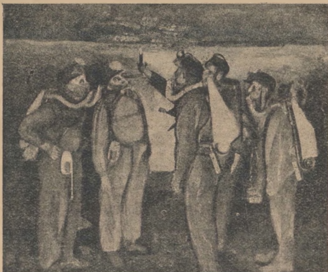
Рис. 99. Спасательный отряд в копях, снабженный стальными цилиндрами с кислородом. Цилиндры укреплены за спиной. Кислород из цилиндра поступает в резиновый мешок, а оттуда по трубе к маске, надетой на лицо.
